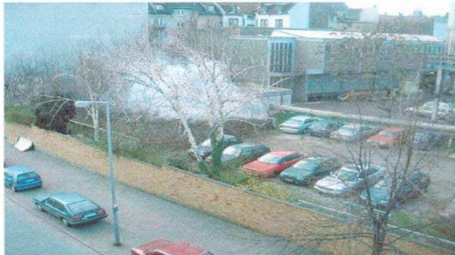
„Alte“ Abluftreinigung mit dem vorhandenen Biobeet
