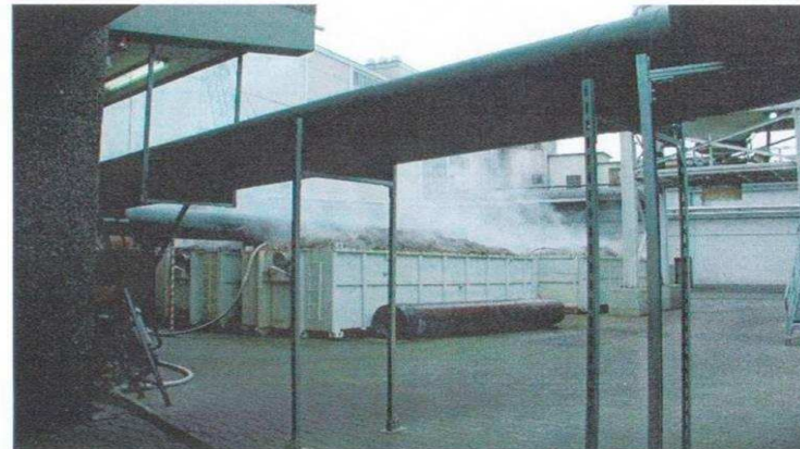
Zwischenlösung während des Baues der neuen Anlage
