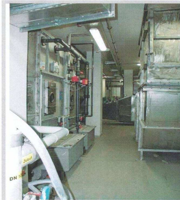
Wäscher zur Kühlung und Fettabscheidung
