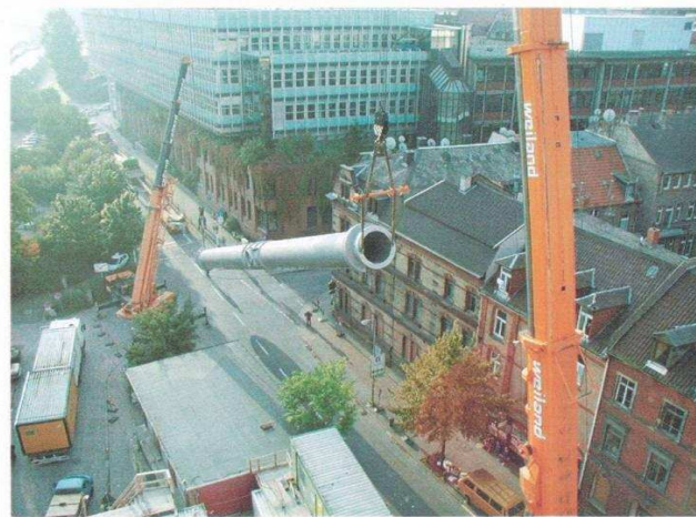
Aufstellen des 30m hohen Edelstahlkamines
